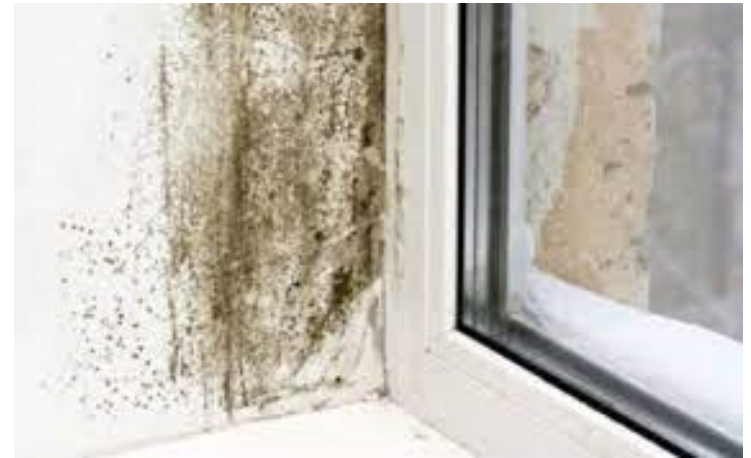
Nouveau châssis double vitrage HR sans grille de ventilation
