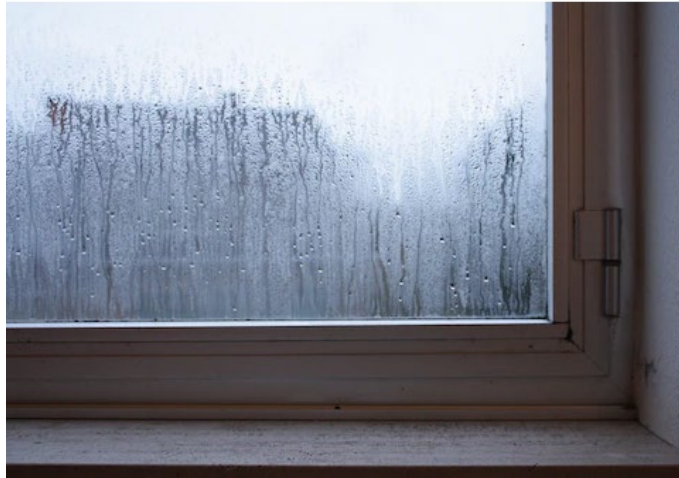
Simple vitrage / ancien double vitrage
