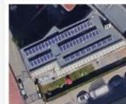
Crèche Reine Fabiola Jette Rénovation globale
