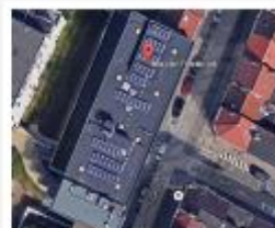
Commune de Jette Rénovation globale
