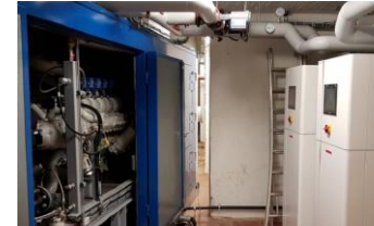
ACP MARIUS RENARD cogénération, isolation toiture
