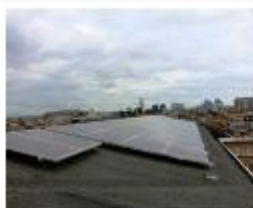
Ecole Van Helmont à Jette Rénovation globale
