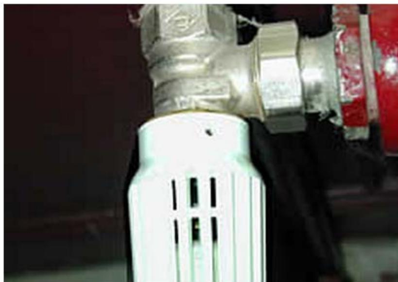
*Vanne institutionnelle : le réglage de la consigne n'est pas accessible à l'occupant, elle résiste aux chocs (même d'un ballon de basket .) et ne peut être facilement démontée.*
