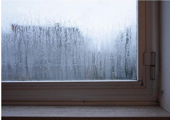
Simple vitrage / ancien double vitrage
