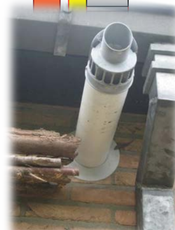
« Ketel met dubbelwandige concentrische pijp »
